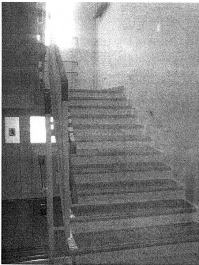
Фото 19 Лестница внутри здания
